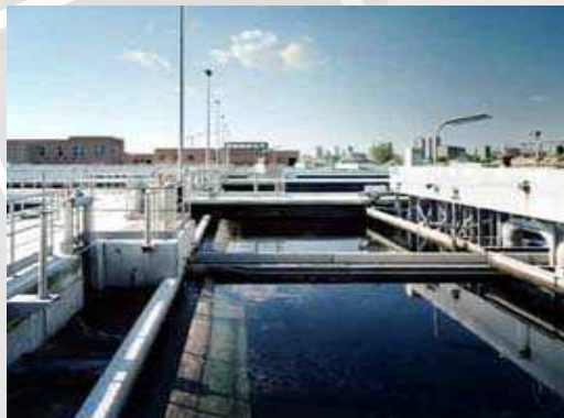
Impianti di depurazione
