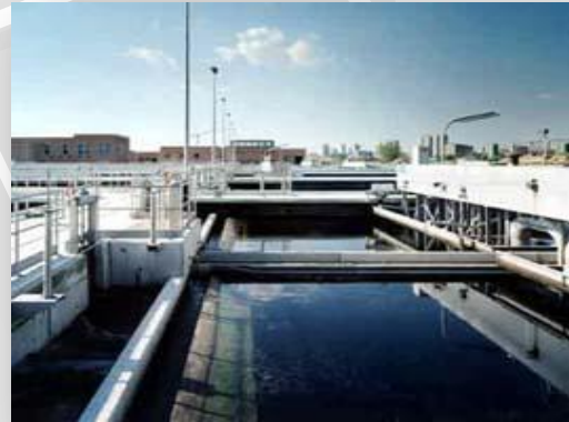
Impianti di depurazione
