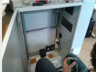
Installazione pompe di aspirazione
